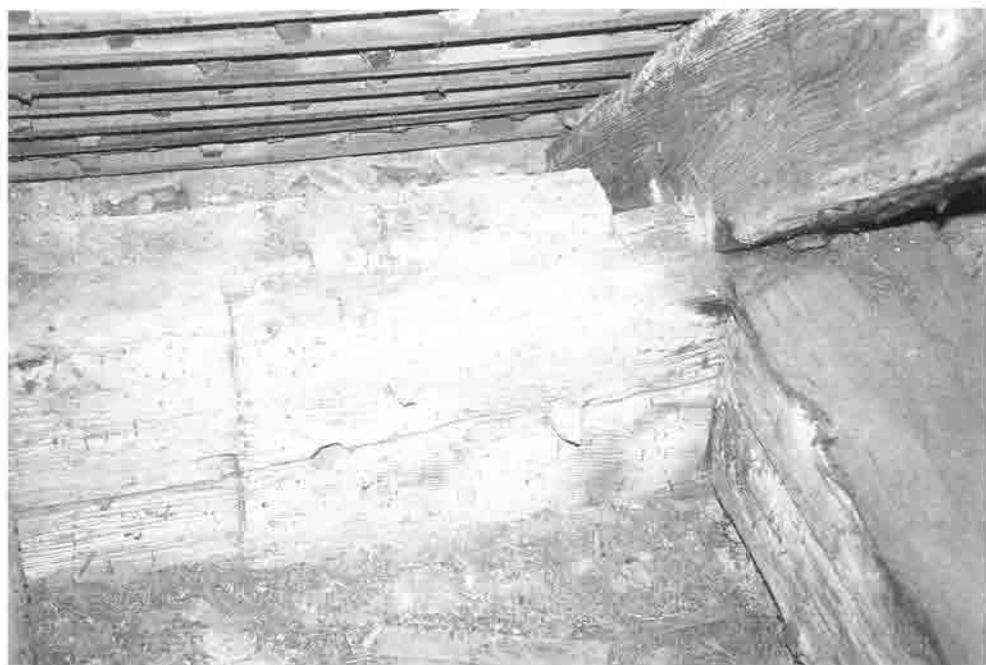
Abb. 3 a, b: Kloster Maulbronn, Klosterkirche. Dachwerk Mittelschiff, Varianten der Mauerholzstöße (1171/72 d).
